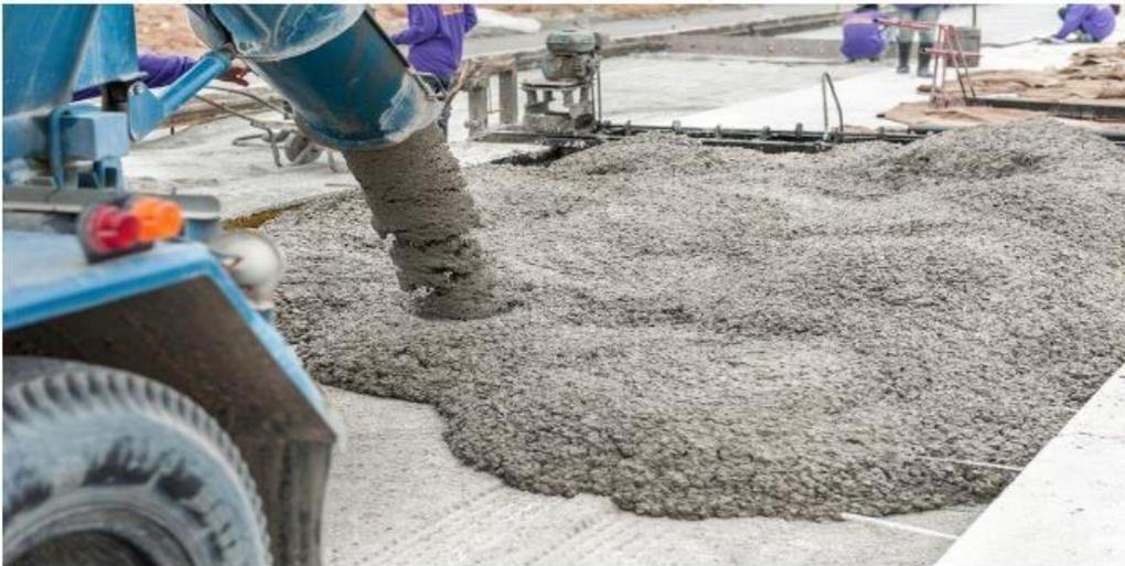
**Figure I.1** : Le béton prêt à l'emploi (BPE). [3]
