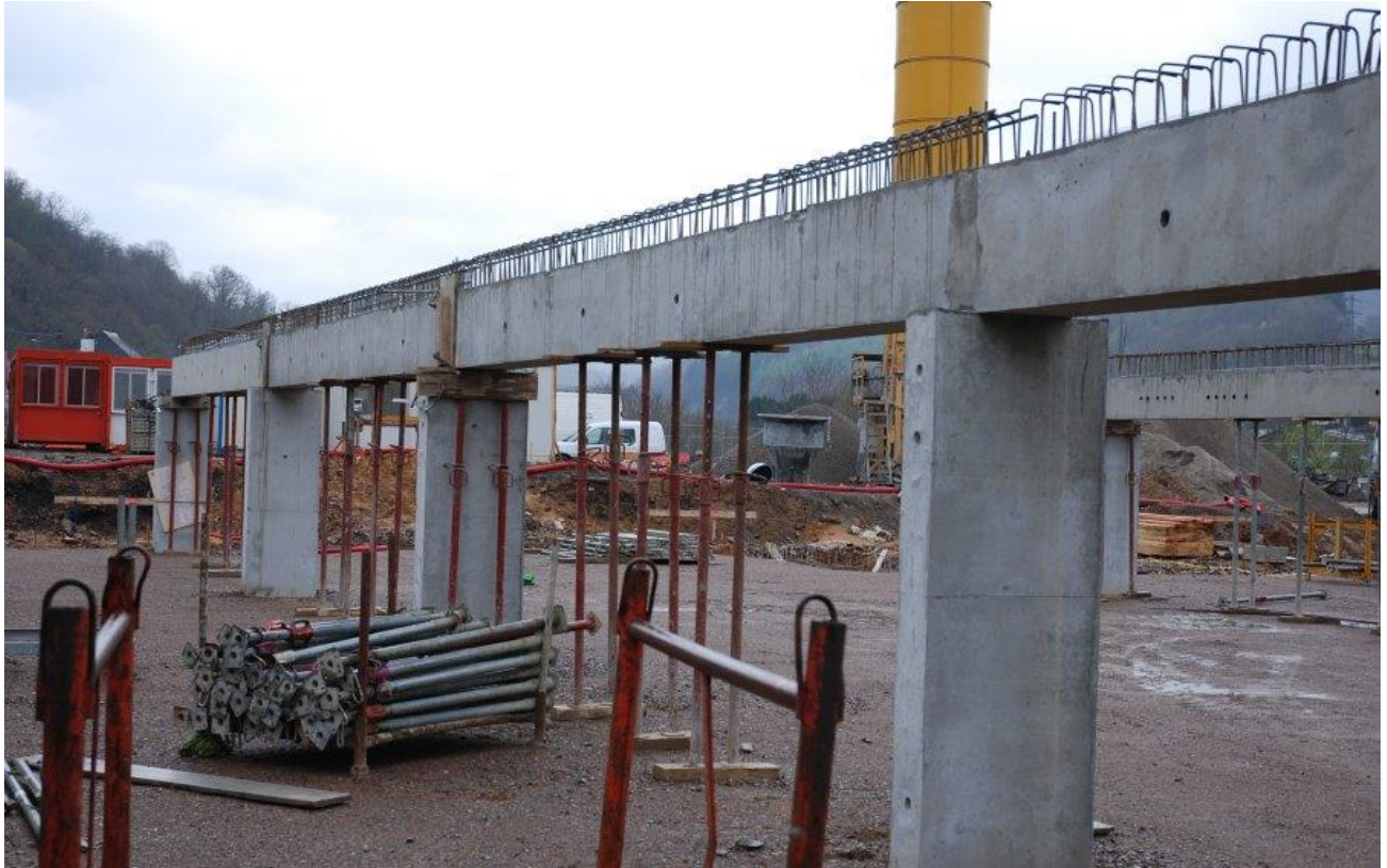
Figure 1.1 : Poutre en béton armée.
