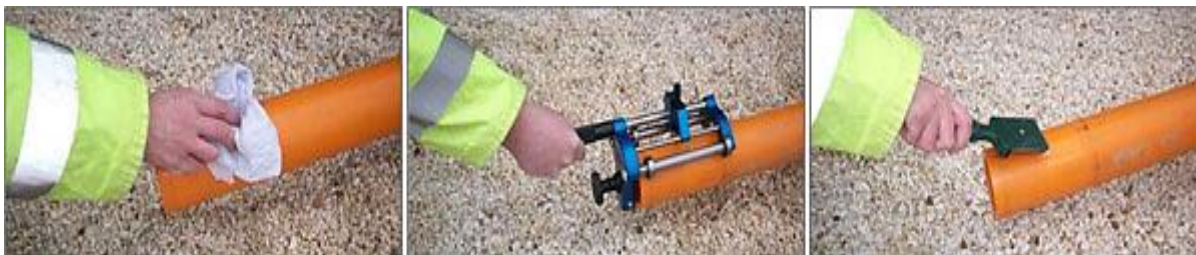
Figure 10 : Grattage de la surface du tuyau à souder.
