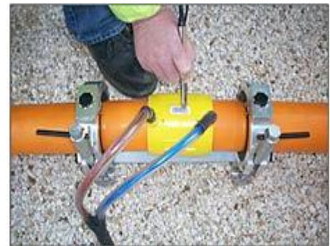
Figure 12 : la machine de soudage et l'aligneur.
