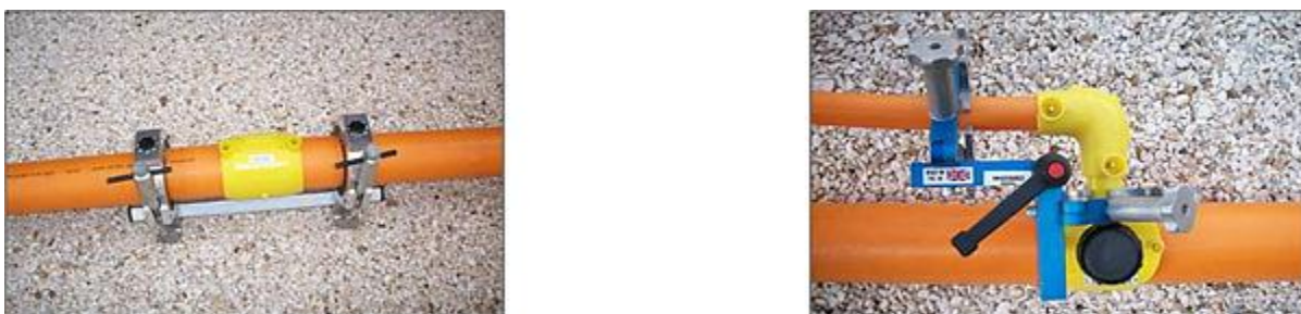
Figure 11 : Alignement des tuyaux.
