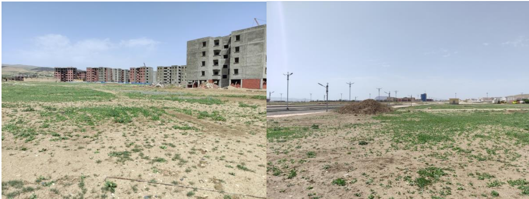
Figure 3.1 Obstacles constatés sur le site d'étude, réseau hydrographique et lignes électriques de haute tension
