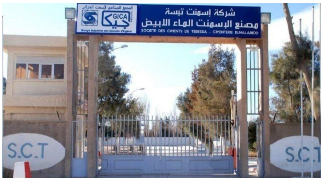
figure : Portail dentré dentreprise miniere
