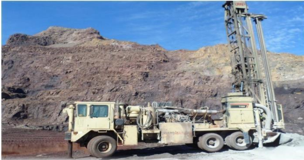
Figure II.13: La sondeuse INGERSOLL-R(T4BH900HR4) en travail de mine de l'El-Ouenza. (BAIZID Mohamed - MESSAOUD Bilal, 2017)
