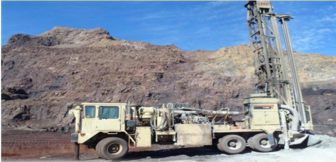
figure 12:La sondeuse INGERSOLL-R(T4BH900HR4) en travail de mine de l'Ouenza. [3]
