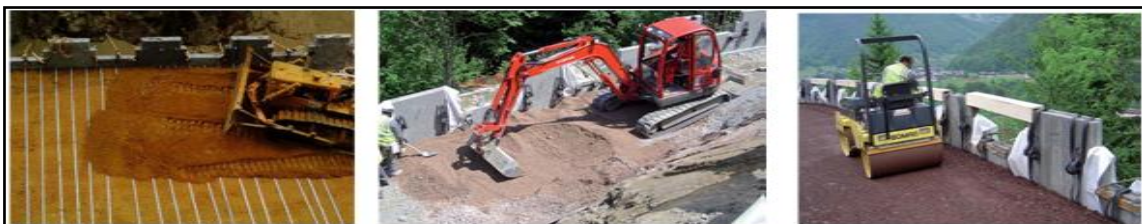
Figure 3.20. Remblaiement et compactage
