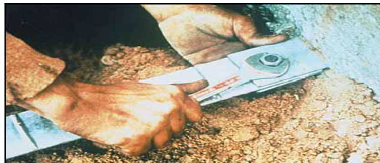
Figure 3.22. Dispositif de fixation d'une armature métallique
