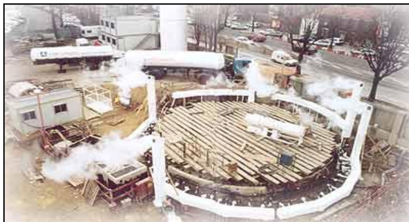
Figure 1.16. Amélioration des sols par congélation (la méthode ouverte à l'azote liquide)
