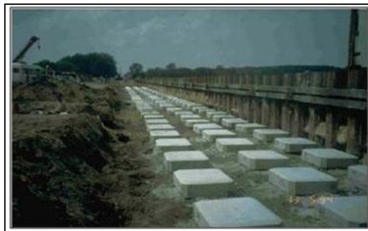
Figure 2.10. Chantier de remblai ferroviaire, visualisation des têtes d'inclusion avant l'édification du remblai
