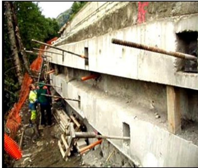
Figure 6.14. Renforcement par ancrage
