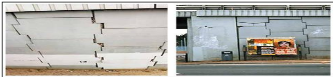
Figure 3.35. Mouvement d'écailles dû à un tassement différentiel
