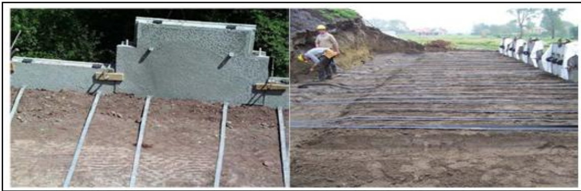
Figure 3.21. Pose du premier lit d'armature
