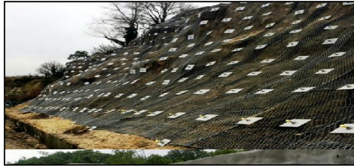
Figure 6.15. Renforcement d'un talus par clouage
