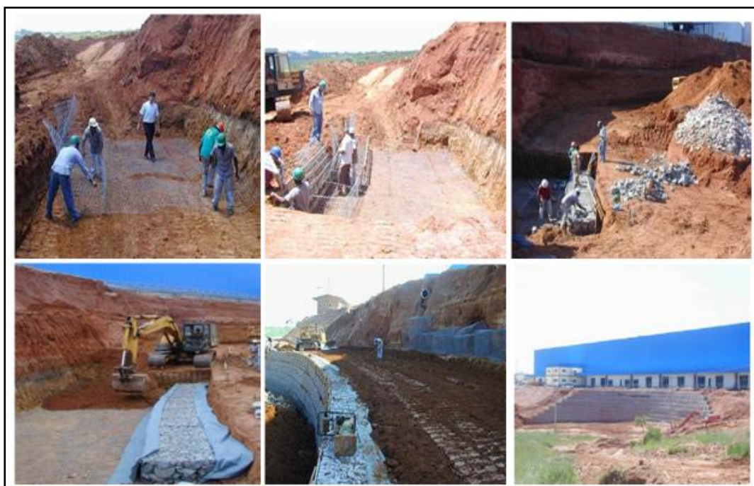
Figure 3.25. Processus de construction d'un mur « Terramesh »
