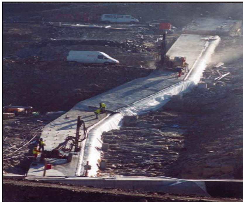
Figure 1.16. Exemple d'application de forage pour injection près d'un barrage
