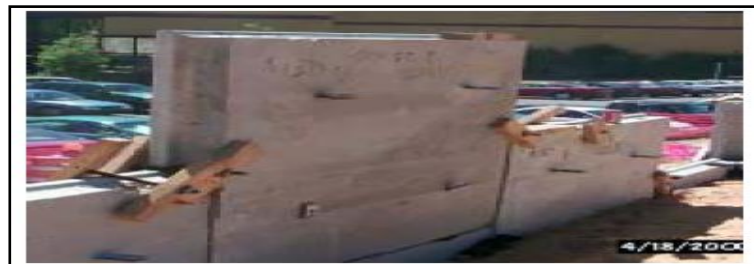
Figure 3.19. Installation des serre-joints sur les écailles placées
