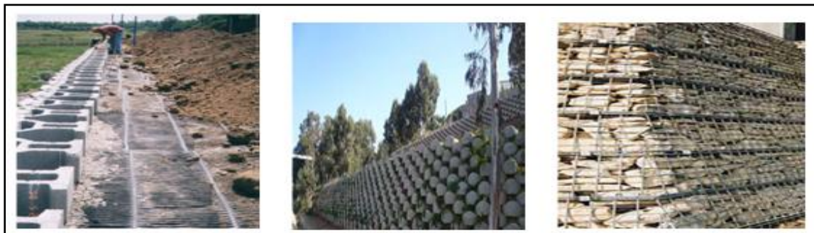
Figure 3.12. Parement en blocs préfabriqués et en grillage d'acier
