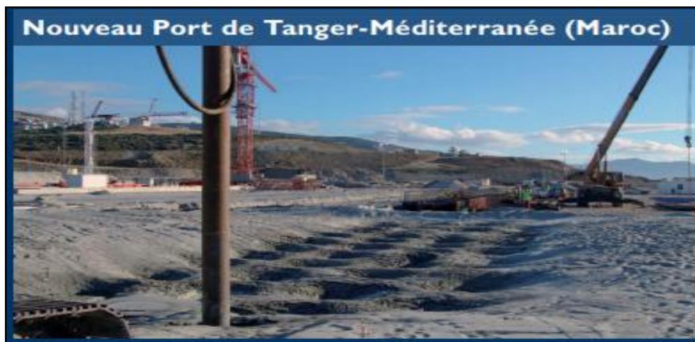
Figure 1.13. Le vibro-compactage, exemple de chantier
