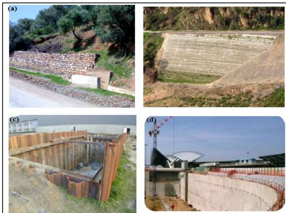
Figure 6.13. Type d'ouvrages souples
