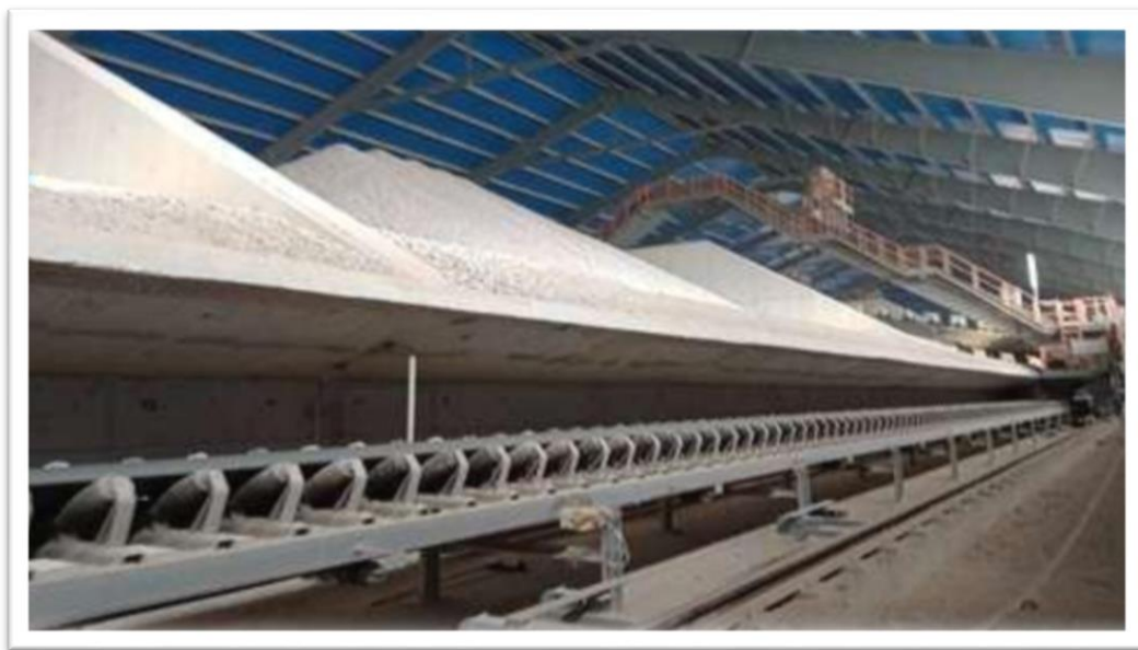
Figure 12 :Méthode de stockage en strates .Collecteur à portique
