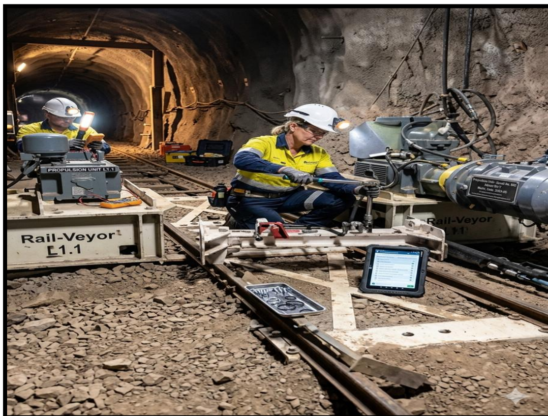
Figure III.12 : opérations de maintenance et inspection technique d'une unité de propulsion Rail-Veyor en environnement souterrain.
