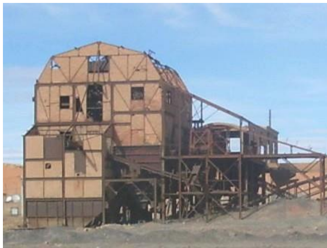
Figure 4.8 : Vestiges industriels de la mine de charbon de Kenadsa — Structure métallique du lavoir et installations de triage abandonnées dans le paysage saharien.
