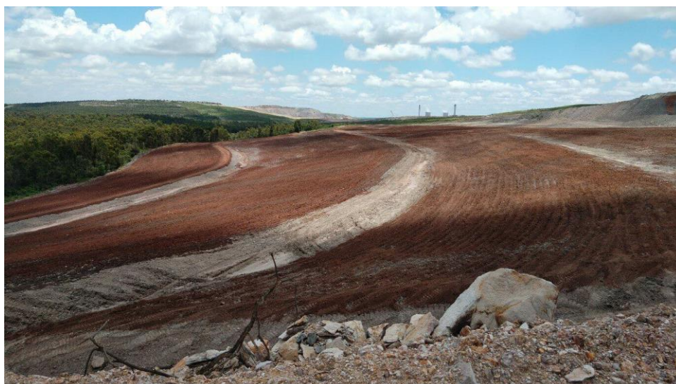
Figure 3.1 : Réhabilitation progressive d'une mine à ciel ouvert — remise en état des talus et préparation des sols pour la revégétalisation
