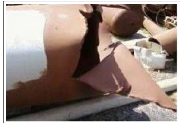
FIGURE 2.8 – Éclatement d'un pipeline [19]
