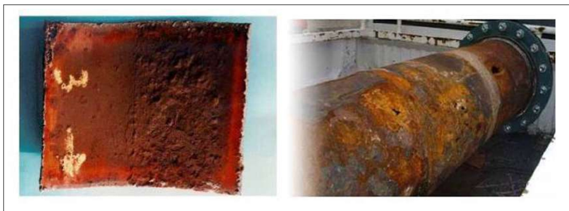
FIGURE 2.18 – Corrosion dans la pipe interne et externe [19]
