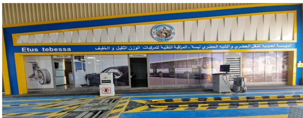
Figure 46: Façade principale du centre technique de l'ETUS Tébessa
