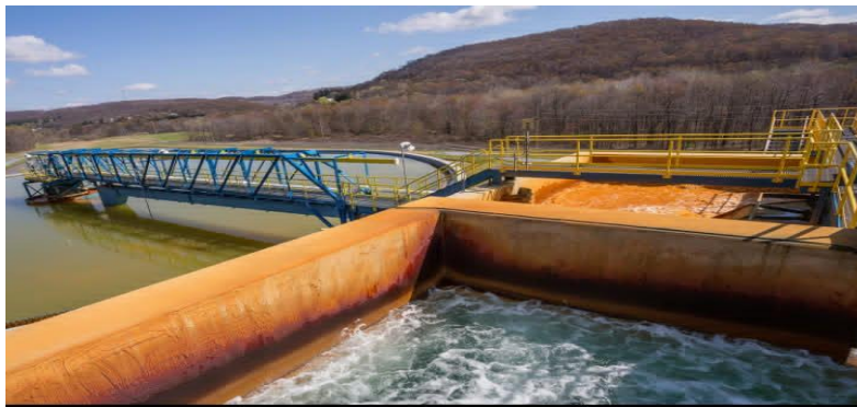
Figure IV.10 : Système de collecte et de traitement des eaux de drainage contaminées.
