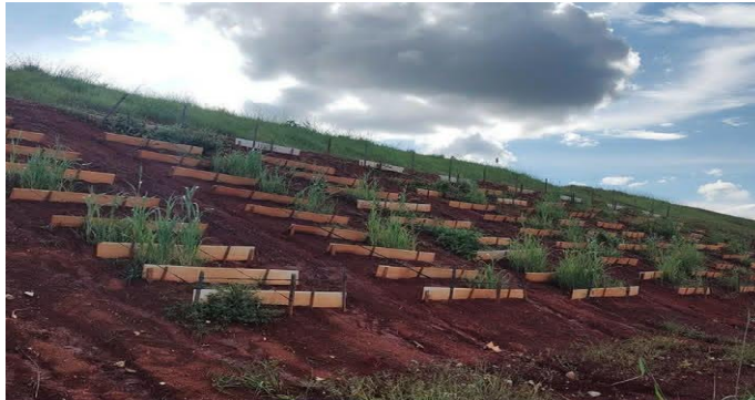
Figure IV.9 : Revégétalisation des résidus miniers pour assurer la stabilité des sols et réduire l'érosion.
