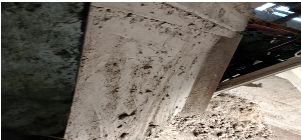
Figure I.17 : Filtration de concentré de flottation de blende Zn.
