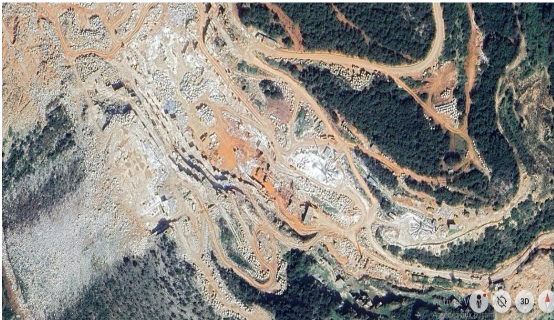
Figure 2.1 : Vue aérienne de la carrière de Filfila montrant le front de taille et la disposition des gradins (Source : Google Earth, 10/04/2026)
