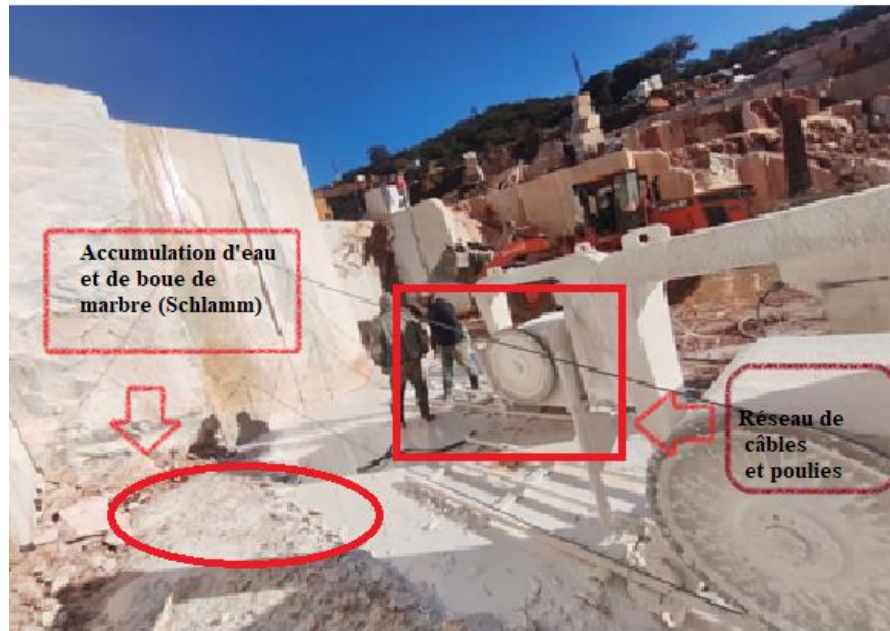
Figure 2.9: Accumulation importante de boue blanche sur la plate-forme de travail, démontrant un débit d'eau empirique et non contrôlé (Cliché personnel, 25 février 2026).
