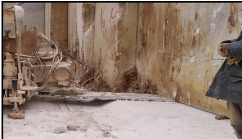
Figure 2.2 : Haveuse à chaîne en opération sur le front de taille – Unité d'exploitation de Filfila (Cliché personnel, 14 février 2026).
