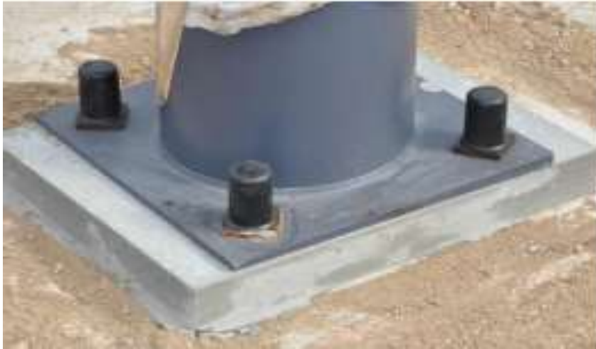
Figure 4.5 : Calage d'un poteau en charpente métallique.
