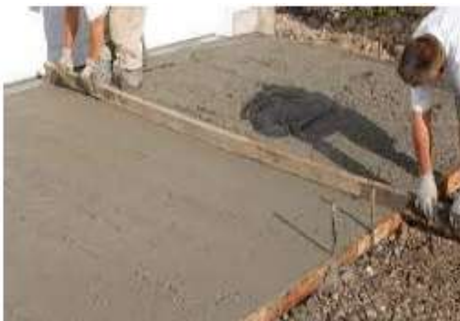
Figure 4.4 : Application d'enduit pour chape.
