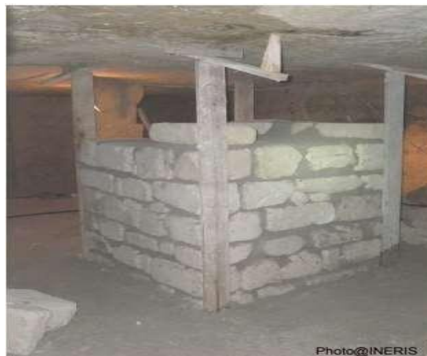
Figure 1.17 Construction d'un pilier maçonné.
