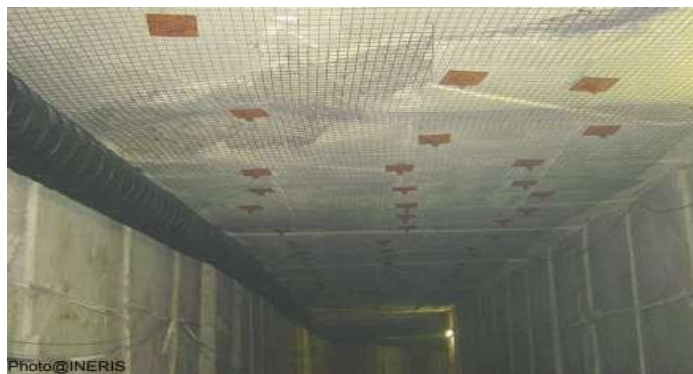
Figure 1.15 Boulonnage du toit d'une galerie.
