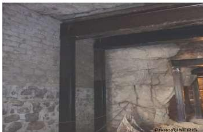
Figure 1.18 Soutènement par portique.
